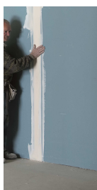
« Le Touché # 1, Anonyme, chantier Metronum. Recadrée.
