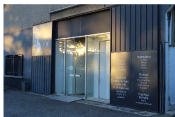
Façade du BBB centre d'art
